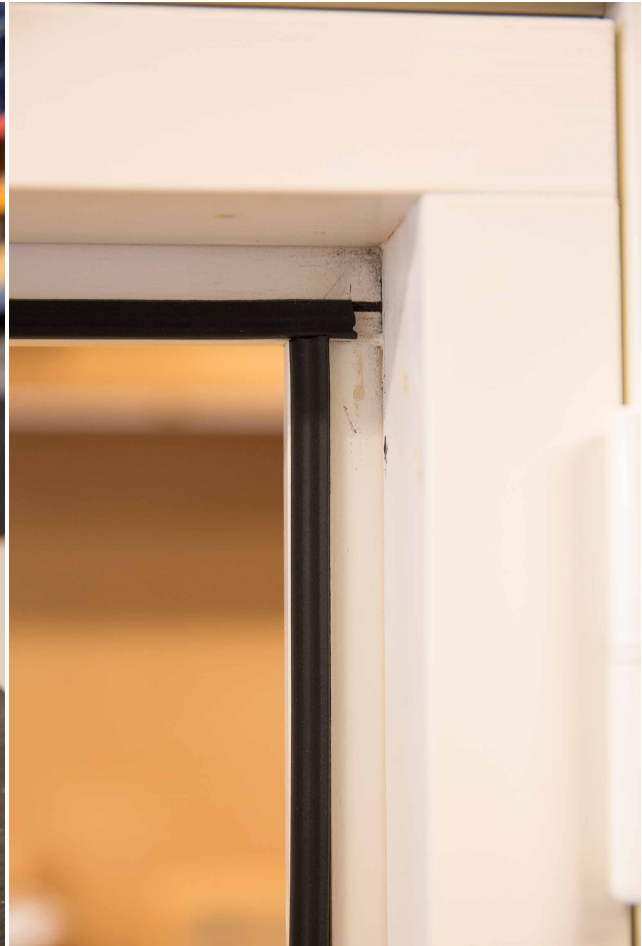
Glasspakninger i hjørne.
