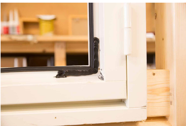
Tetting/liming i hjørne.
